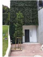
参道エレベーター
